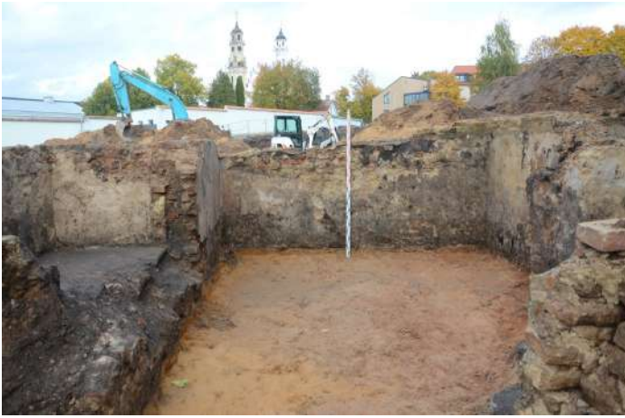
901. Gyvenamojo namo Nr. P3 fragmentai – patalpa 2. Vaizdas iš PV.
