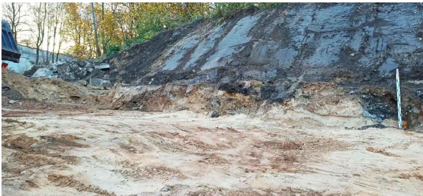
1325. Žvalgymai niveliuojant sklypą R, PR sklypo dalyje. Vaizdas iš ŠV.
