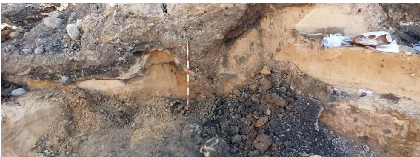
638. Perkasa Nr. 21 – R sienelės dalies griūtis. Vaizdas iš R.
